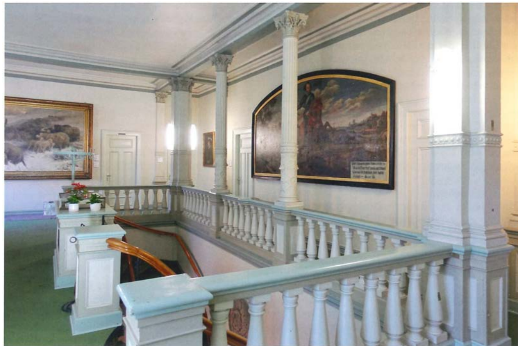
2 Obergeschoss vor der Restaurierung, Aufn. 2017.
